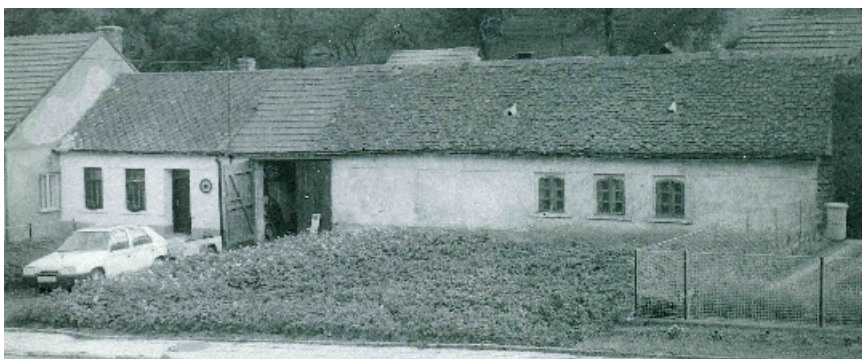
Původní vzhled domu č. p. 11 před vybudováním penzionu.
